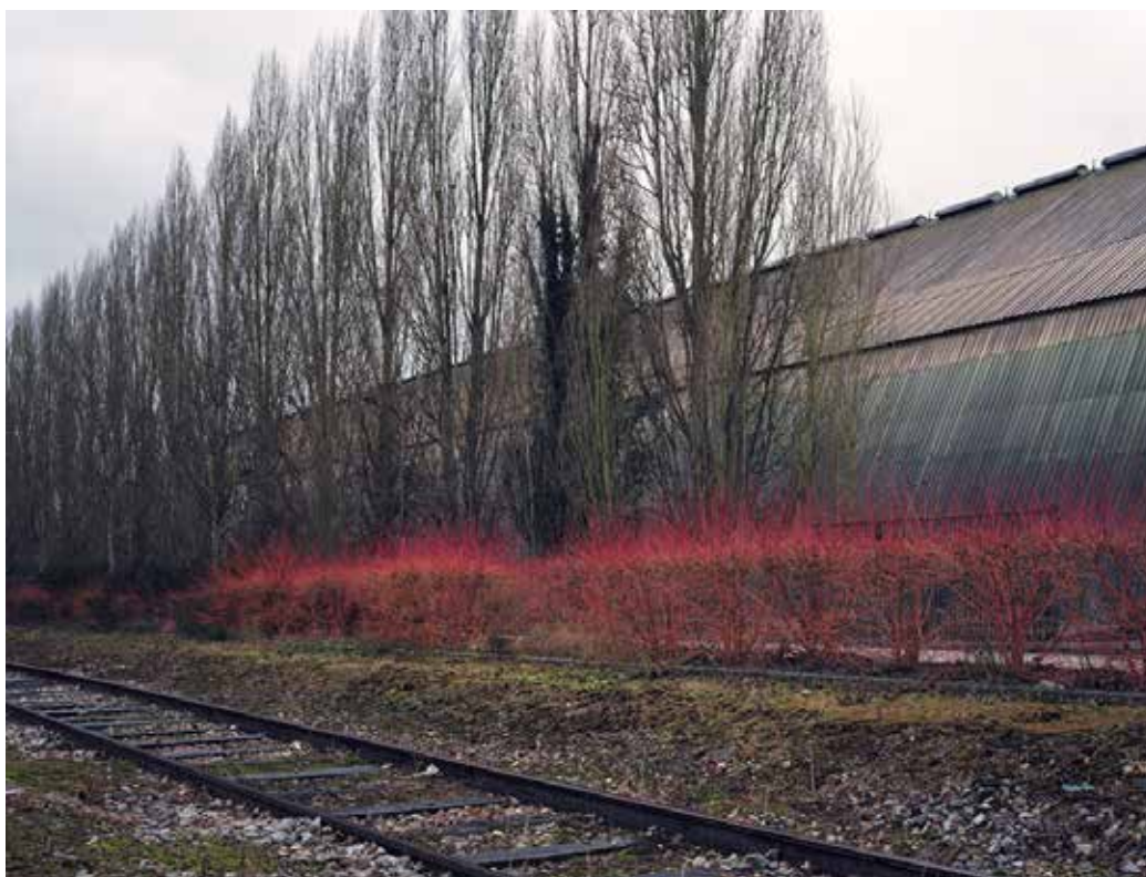
L'une des deux installations - Rubis
